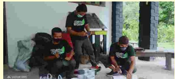
Team lapangan membuat dan persiapan bahan dengan memotong pipa paralon yang akan digunakan untuk lubang biopori, adapun target dari penyediaan lubang resapan biopori adalah 60 lubang yang akan tersebar di beberapa sekitar gedung Kebun Raya Balikpapan
